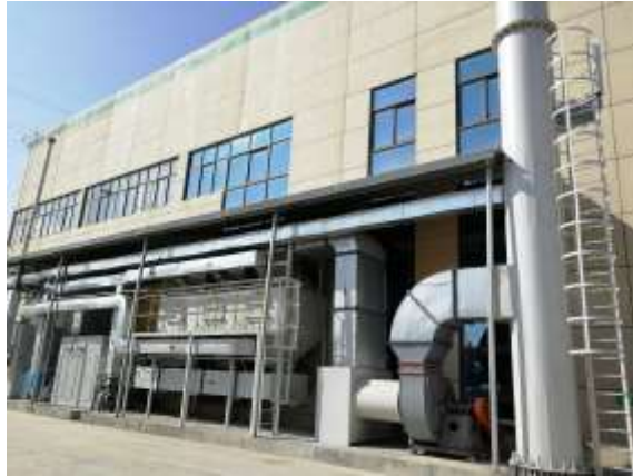
干式喷漆废气处理设施
