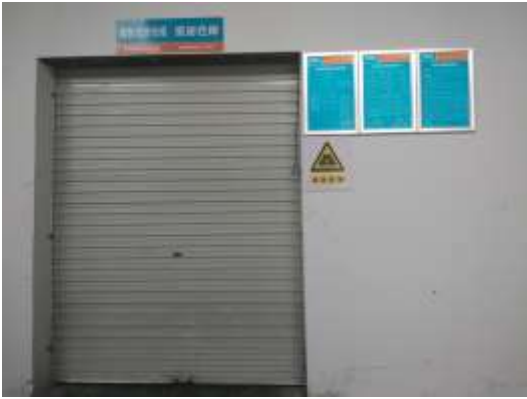
废乳化液、废油暂存间
