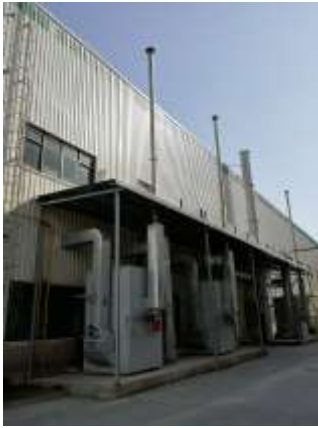
浸漆废气处理设施及天然气燃烧器
