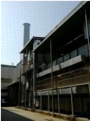
浸漆废气处理设施及天然气燃烧器
