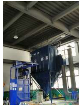
Q1-Q6 喷漆废气处理设施
